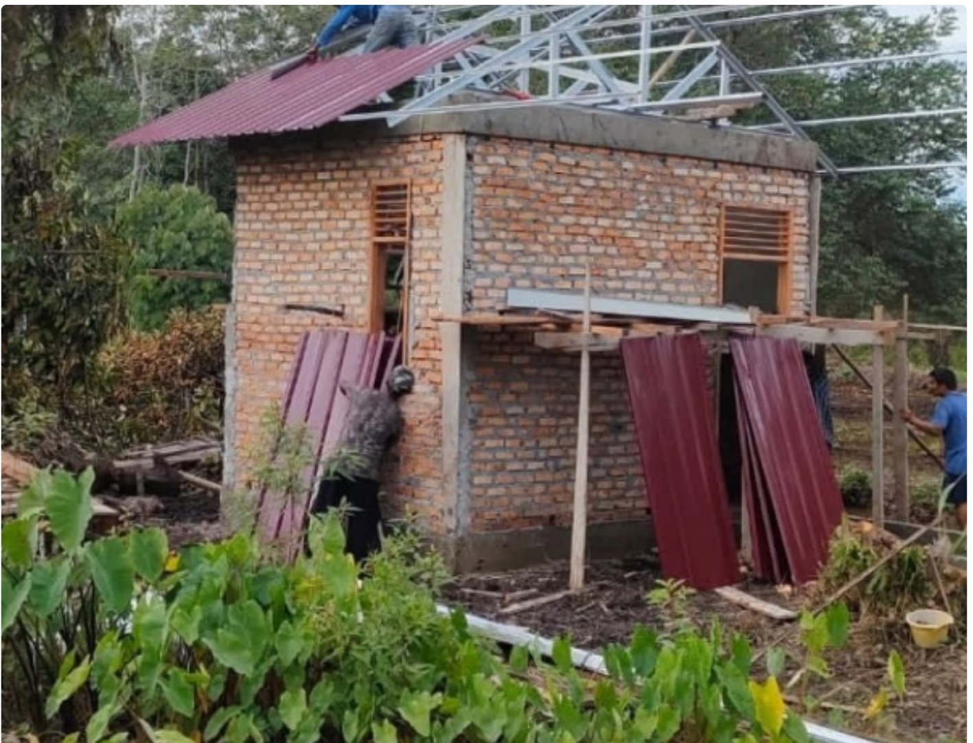
Progres pembangunan rumah Syahrudin desa teluk Latak
